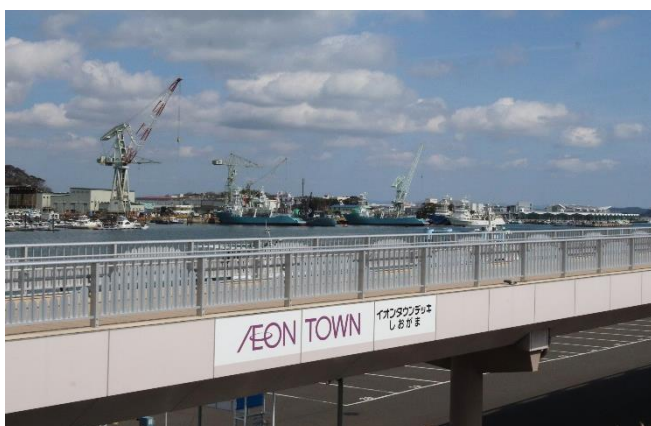
▲松島方面デッキ桁面
