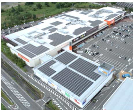
脱炭素の取り組み（太陽光PPA）
