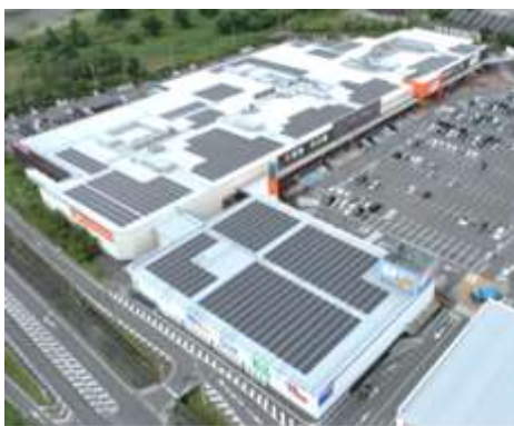
脱炭素の取り組み（太陽光PPA）
